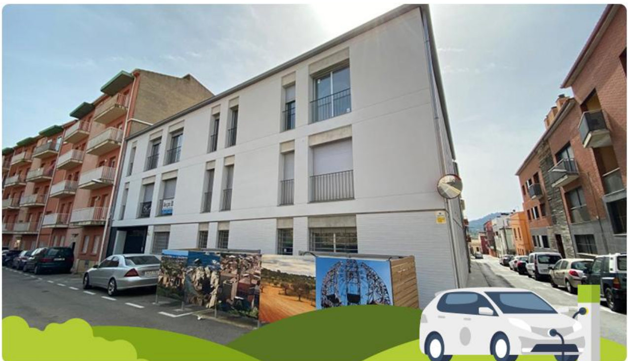
Bloc d'habitatges cooperatius per a joves a Calonge
